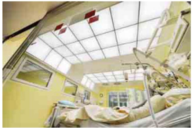
**Abb. 3** ▲ Zumtobel-Lichtdecke: Spezielle Lampen über den Patientenbetten simulieren das Tageslicht bei Sonnenschein. Lichttemperatur und -intensität lassen sich tageszeitabhängig programmieren. C: Helge Bauer
